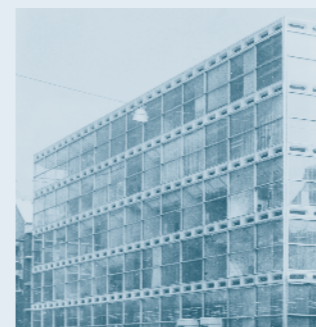
13 1973 Medicor színház homlokzata, Budapest XIII., Visegrádi utca (alapvetően átépítve) Gulyás Zoltán munkatársaként
