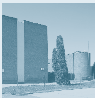
22 1976 VIDEOTON Kalapácpadgyártó csarnok és fejpület, Székesfehérvár, Vadász utca (a gyártócsarnok homlokzata átépítve)
